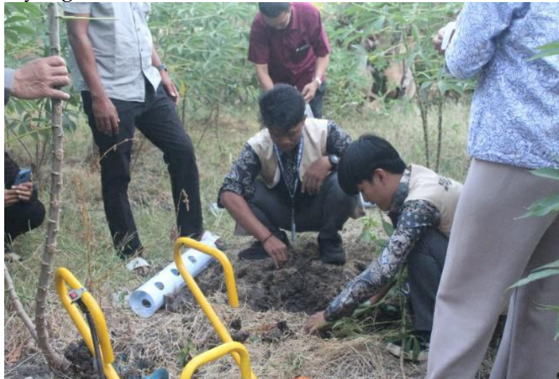
Gambar 3: Praktik Pembuatan Lubang Resapan Biopori
