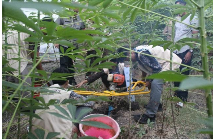
Gambar 4: Praktik Pembuatan Lubang Resapan Biopori
